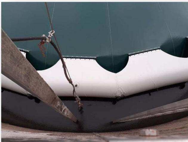
*Système Nénufar flottant sur du digestat dans une cuve de stockage*
