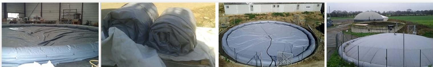
Fabrication en atelier, transport et installation de la couverture
