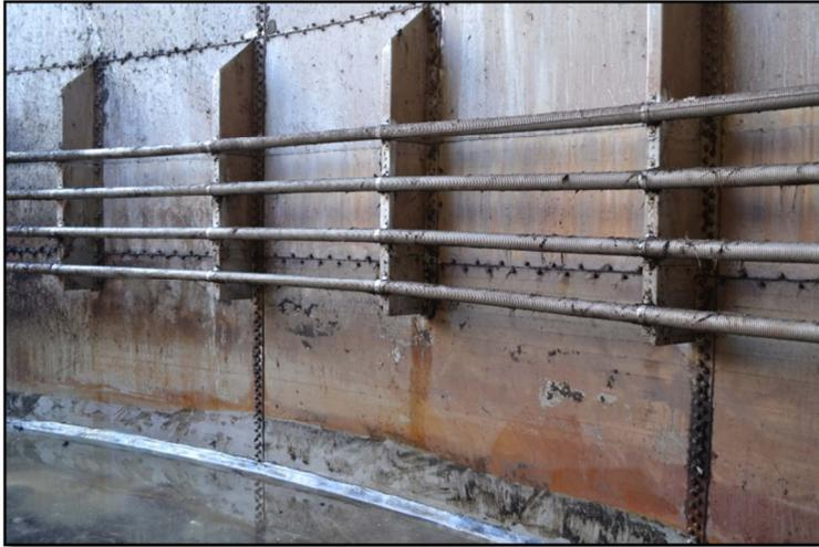
Réseau de chauffage fixé sur les parois internes du digesteur
